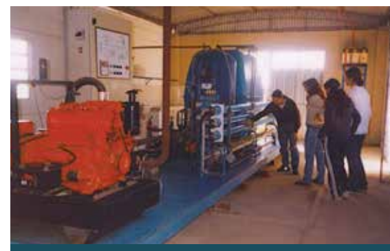
Con su trabajo, el grupo de estudiantes logró que se instalara una planta potabilizadora con el proceso de ósmosis inversa, que fue donada por los Ministerios de Acción Social de la Nación y la Provincia.
