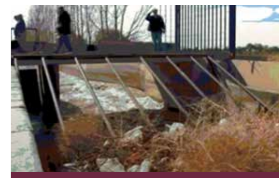
Parte del proyecto "El agua es vida, cuidémosla entre todos" consistió en el diseño y fabricación de un dispositivo para evitar la acumulación de la basura en las acequias.
