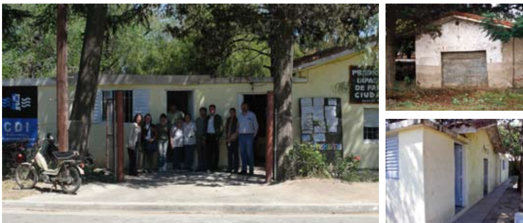
La piecita original cedida por DIPAS (derecha, arriba), parte de las ampliaciones realizadas a partir del curso de albañilería (derecha, abajo) y la sede de la Junta de Participación Ciudadana hoy.
