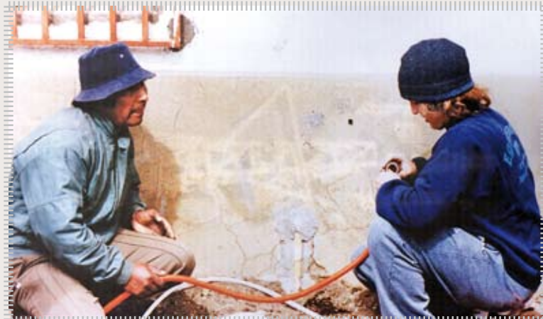
Un alumno y un poblador realizan la instalación eléctrica para un generador eólico en la Escuela N°259 de la comunidad de Atreuco.
