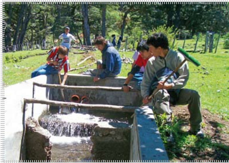
Preparación de la toma de agua de una turbina a hélice instalada en la casa de Elsa Cañicul en el lago Huechulafquen.
