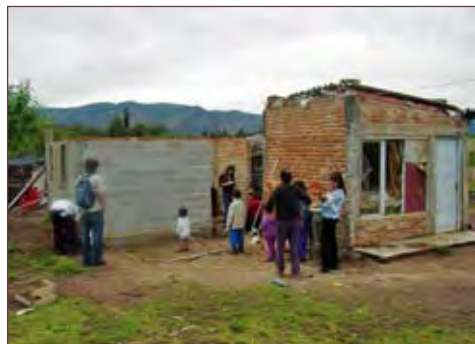
Cosquín: mejoramiento en la vivienda monoambiente de una familia de 9 miembros.
