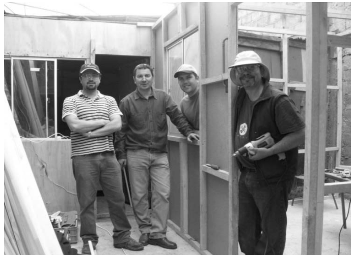
Imagen N° 1: Faena de construcción de paneles.
